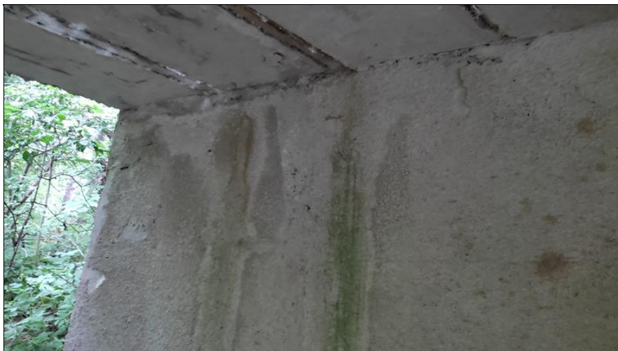
Stopy po zatékání ze spár mezi nosníky
