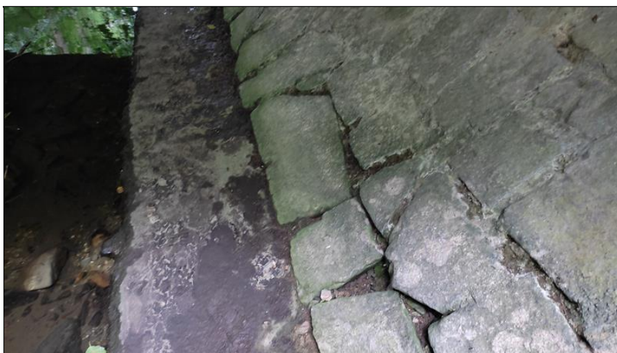
Detail opevnění koryta
