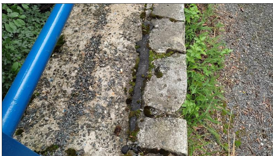
Detail zálivky mezi obrubníky a římsou
