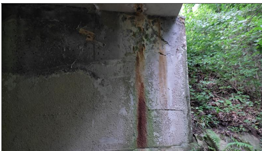
Zatékání mezi nosníky na opěru
